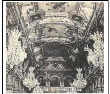
Plafond Salle des Fêtes
